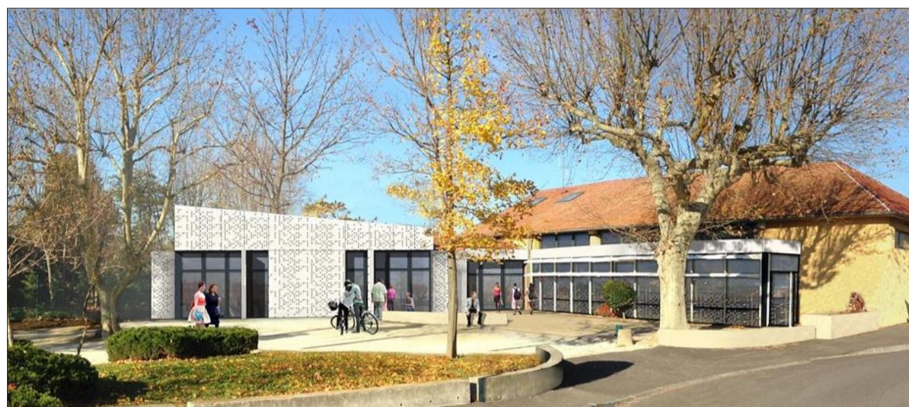
Un bâtiment à la fois rénové et étendu fera appel à des matériaux composites et au métal. • Image d'insertion : B_CUBE architectes •
