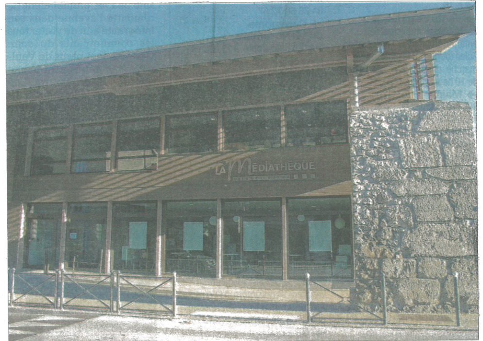
Depuis la mi-octobre, une équipe de bibliothécaires se charge d'aménager les locaux de la nouvelle médiathèque, dont la façade, de bois et de pierre, s'intègre parfaitement à l'environnement.
